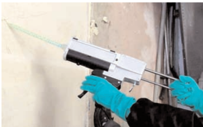
Abbildung 1: Pistole zum Mischen eines Zweikomponenten-PUR-Produktes
